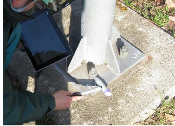
道路附属物のアンカーボルトの点検
