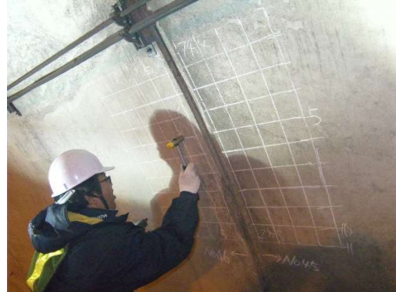
トンネル内覆工コンクリート調査
