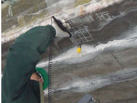
コンクリート桁の強度確認
