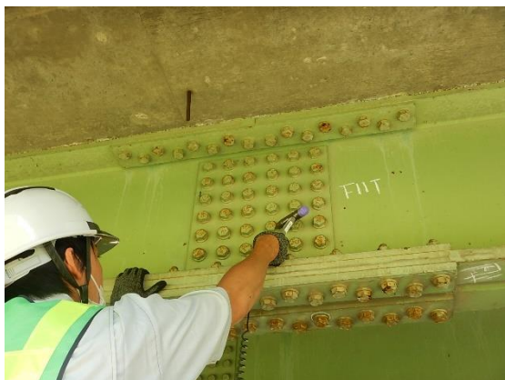
橋梁添接部のボルト・ナットの点検
