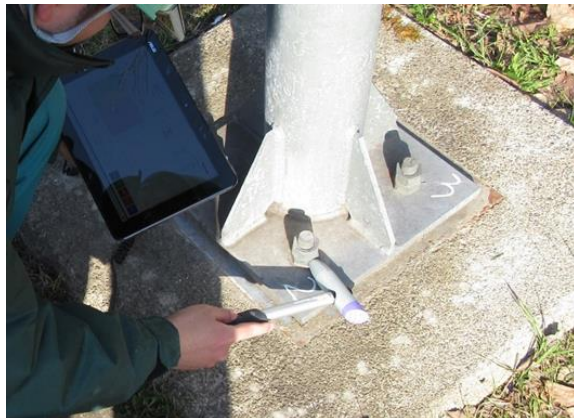
道路附属物のアンカーボルトの点検
