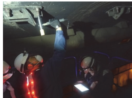
図 5.2.10 ジェットファン点検状況
