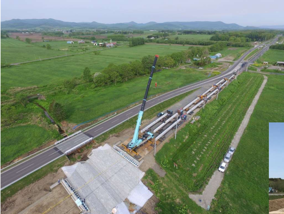
橋梁上部工架設
