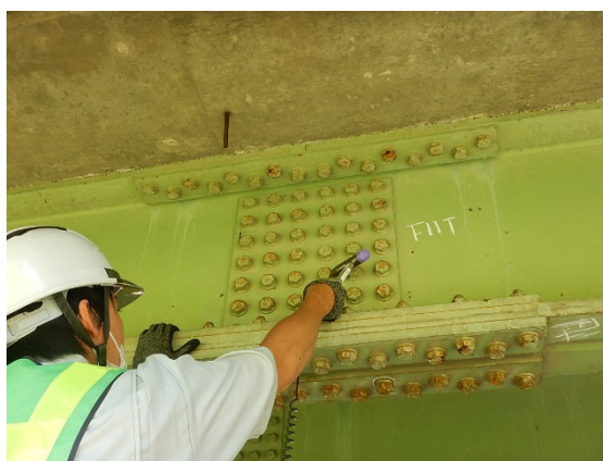
橋梁添接部のボルト・ナットの点検
