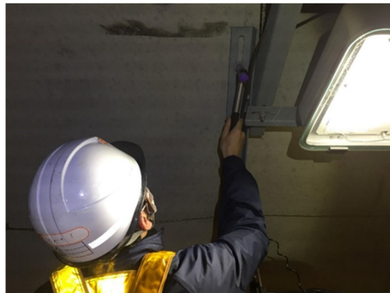
トンネル内照明灯具固定アンカー軸力検査
