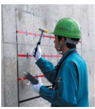
コンクリートの表面を打撃するだけで簡単に測定できる
