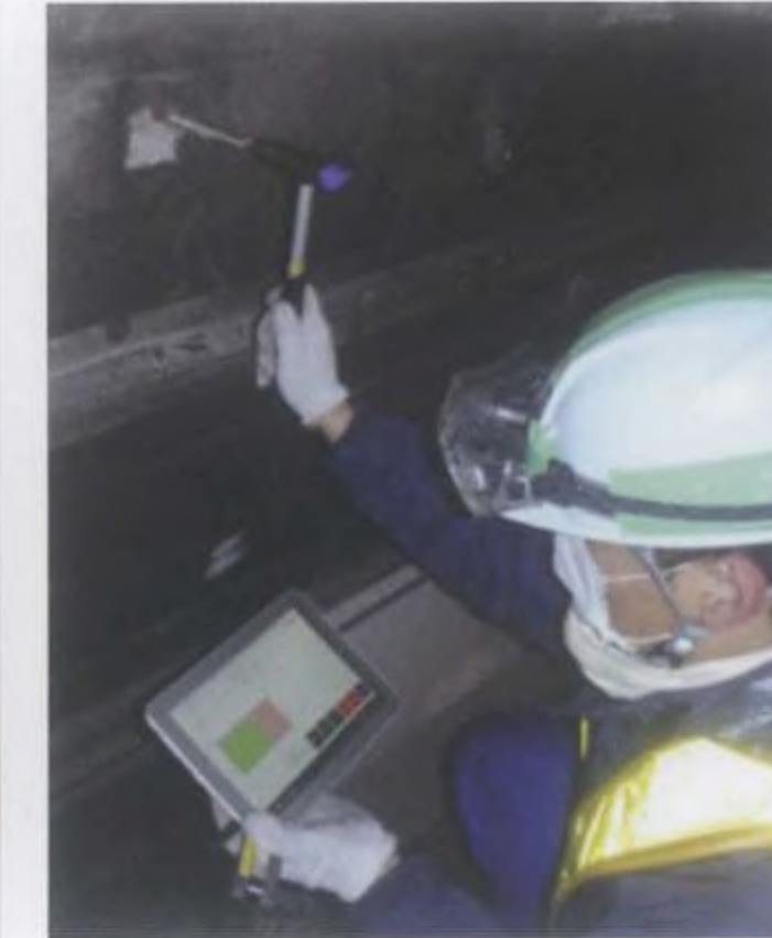
現場での測定状況
