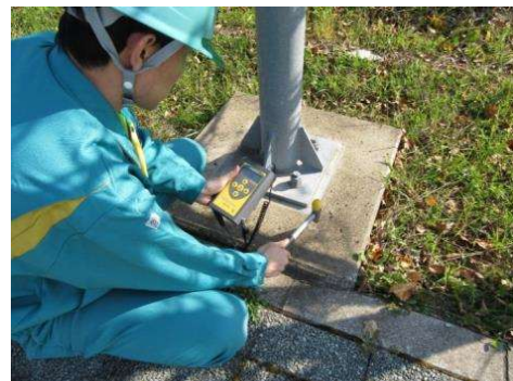
写真4.基礎コンクリートの点検状況(CTS)
