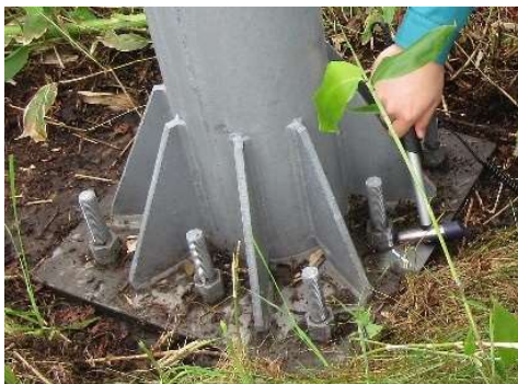
写真3.ナットの点検状況(BTS)
